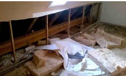
Abbrucharbeiten im Dachgeschoss (Foto: Alex)
